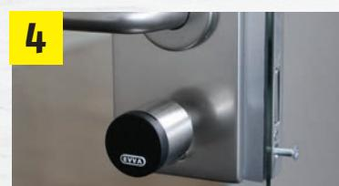
Schieben Sie den Zylinder des gegebenenfalls im Vorhinein zusammengebauten smarten Türschlosses in die leere Vorrichtung. Anschließend schieben Sie die vorhin zur Seite gelegte Sicherheitsschraube in das dafür vorgesehene Loch und ziehen diese Fest.<sup>1</sup>
