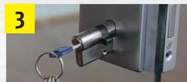
Im dritten Schritt stecken Sie den Schlüssel in das noch verbaute, alte Schloss und drehen ihn so lange, bis Sie den Zylinder ohne großen Kraftaufwand aus dessen Vorrichtung ziehen können.
