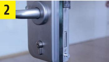
Um das in der Tür installierte Schloss zu entfernen, reicht es, die Sicherheitsschraube herauszudrehen. Diese befindet sich im Normalfall direkt unter dem Schließriegel und kann mit einem Kreuzschraubenzieher gelöst werden. Bewahren Sie die Schraube gut auf.
